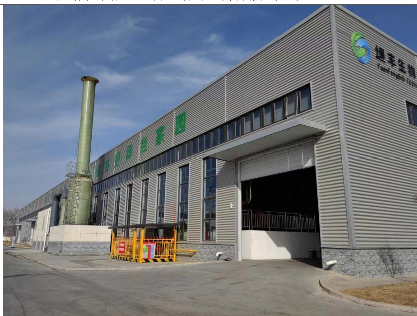
2#排气筒/烘干废气、冷却筛分废气排放口 (DA002)
